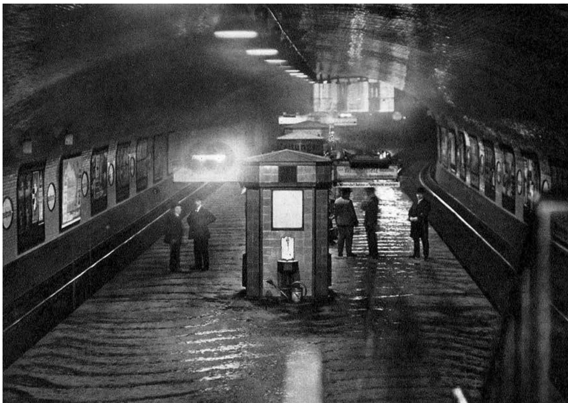
Berlin in Bildern: Podzemna željeznica, Inselbrücke
